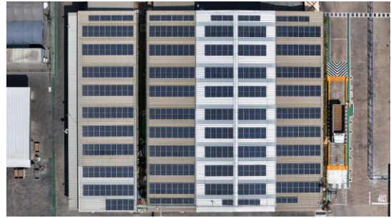
ภาพที่ 2.2-38 แผงเซลล์แสงอาทิตย์ (Solar Module) บนหลังคา (Roof Mounting) ของอาคารผลิต
